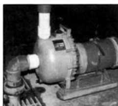
ОЧИСТКА СТОЧНЫХ ВОД
